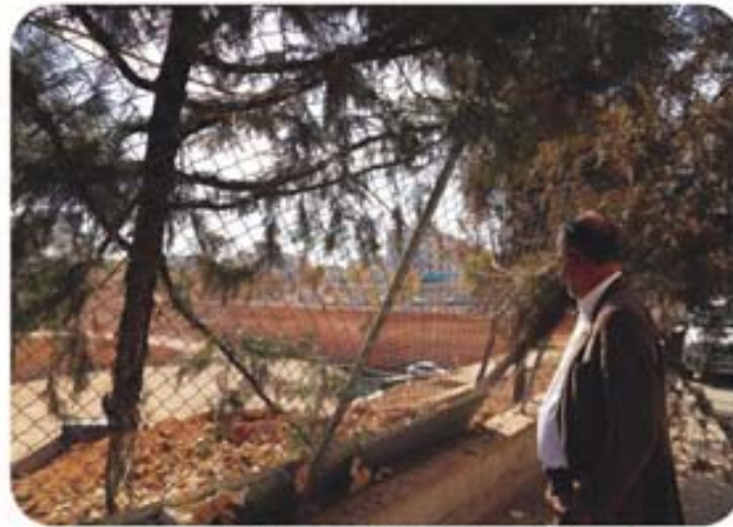
پروژه در حال احداث مرکز مراقبت ژنیمالان خاص
