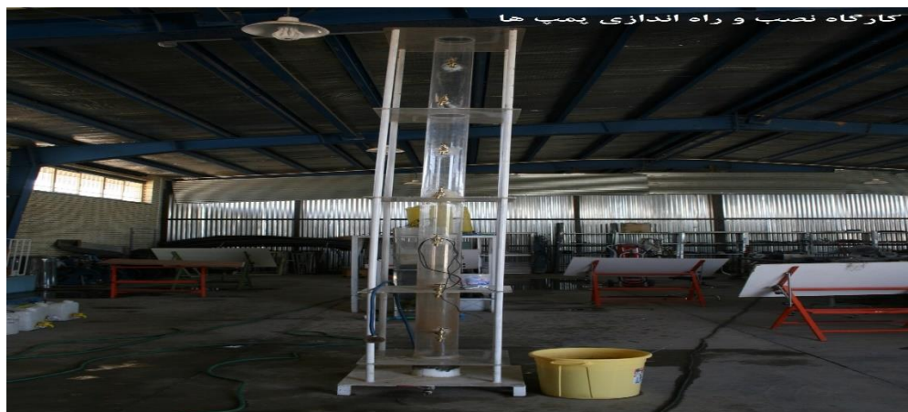
کارگاه نصب و راه اندازی پمپ ها
