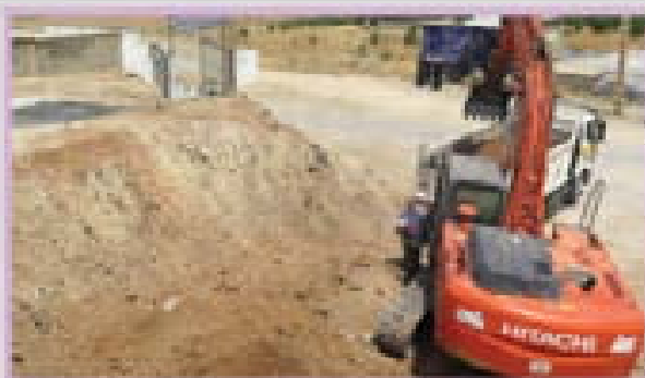
شروع عملیات خاکبرداری کنار درب ورودی بیمارستان امام جواد(ع) ناغان
